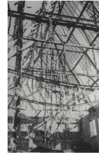
Das zerstörte Dach (1945)
